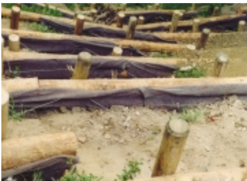
■ durante i lavori
