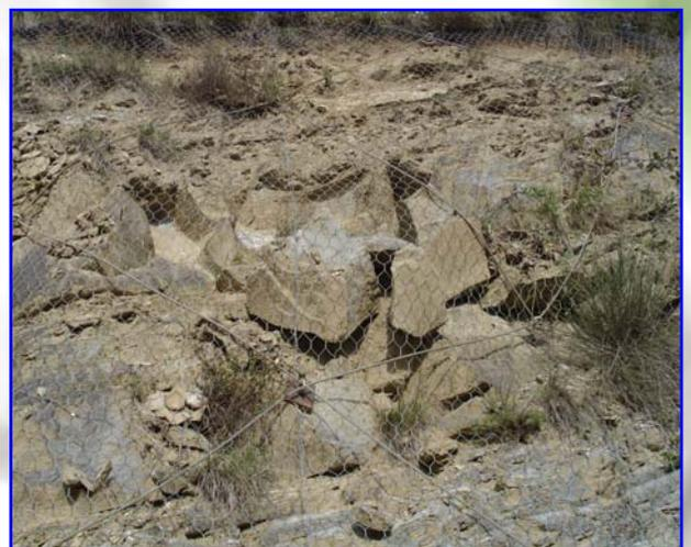
*Foto 4 – La foto mostra l'effetto di ritenzione della rete e del reticolo di funi su blocchi distaccati*
