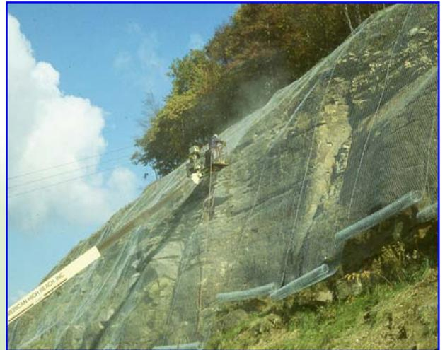
*Foto 1 – Installazione di un intervento paramassi in parete, legatura dei teli di rete a doppia torsione*
