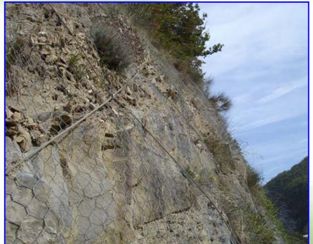
*Foto 2 – Dettaglio di un intervento in parete realizzato con rete paramassi, chiodatura e tirantatura con funi in trefoli in acciaio*
