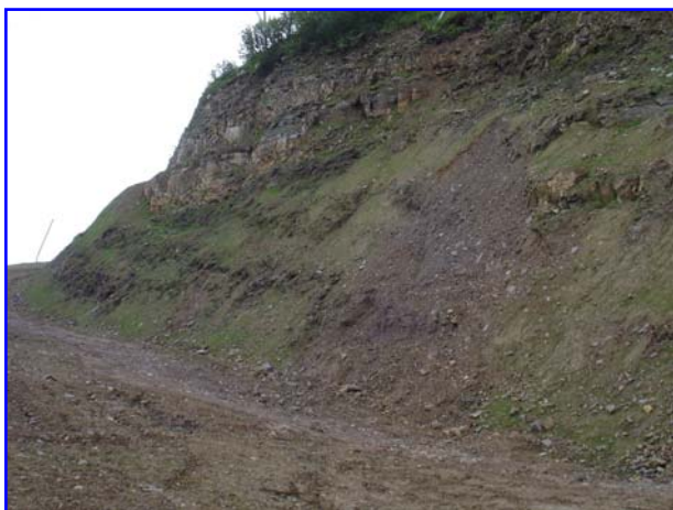
Scarpata a monte di una pista sciistica. La litologia della roccia si presenta fortemente eterometrica e soggetta ad importanti fenomeni di alterazione che ne denudano progressivamente la superficie.
