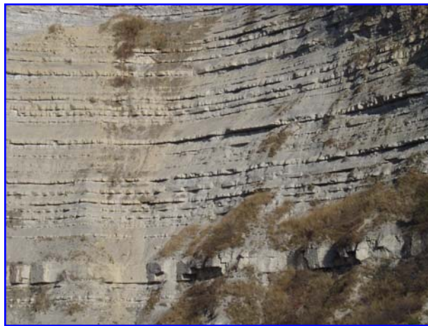
Scarpata di versante in materiale flyschoida ad alternanza pelitico-arenacea, soggette ad erosione di tipo selettivo. Necessitano di idonea protezione sia per scagliettature marnose che per blocchi arenacei.
