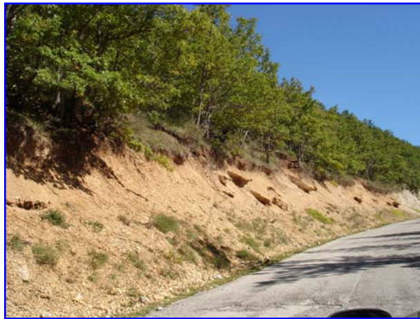
Scarpata stradale in roccia tenera soggetta a fenomeno di perdita di suolo. Una adeguata protezione antierosiva può fermare l'arretramento e innescare un progressivo rinverdimento.
