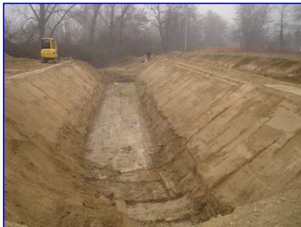
Scarpata fluviale in materiale sabbioso realizzata per la costruzione di un canale. Il pendio necessita nella porzione media e sommatale di una adeguata protezione antierosiva e rinverdimento.
