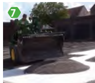
7 posare la ghiaia
