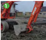
1 effettuare i lavori di scavo
