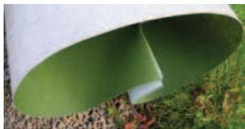
**Foto 2:** Piegare i giunti sovrapposti a forma di Z (come indicato) e applicare una terza striscia di nastro butilico di-adesivo senza rimuovere la carta protettiva.
