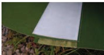
**Foto 3:** Dopo aver piegato bene, rimuovere le carte protettive restanti e pressare insieme con forza. Le radici non riusciranno a penetrare o danneggiare questa giunzione.
