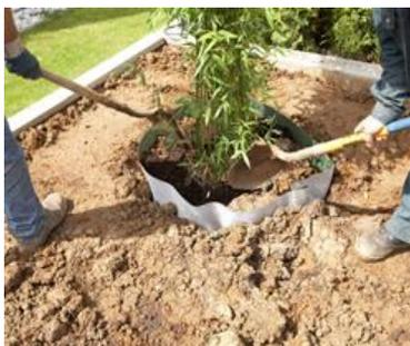
Posizionare la pianta e ricoprire con la terra lasciando 2 cm di non-tessuto RootBarrier Pro al di fuori della superficie.
