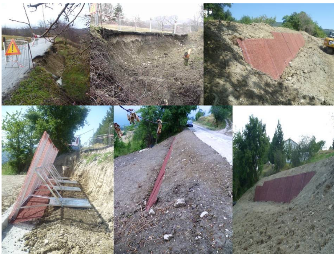
Nelle foto è esposta la sistemazione di un cedimento stradale
