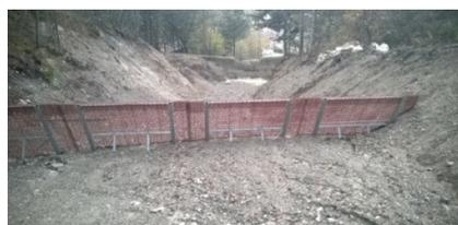
In **ambito idraulico** **SOSTengo**, viene utilizzato per la realizzazione di **briglie “autocaricanti – filtranti”** che, quando sature, possono essere integrate da file successive e/o per **protezione spondale**
