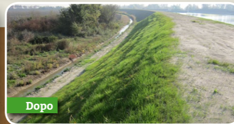
Stabilizzazione di argine di canale pensile mediante piantumazione di sistemi Erosion Control abbinati a idrosemina a spessore.
