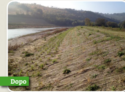
Stabilizzazione di argine fluviale mediante piantumazione di sistemi Erosion Control abbinati a biostuoia in juta
