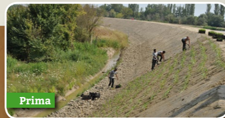
Stabilizzazione di argine di canale pensile mediante piantumazione di sistemi Erosion Control abbinati a idrosemina a spessore.
