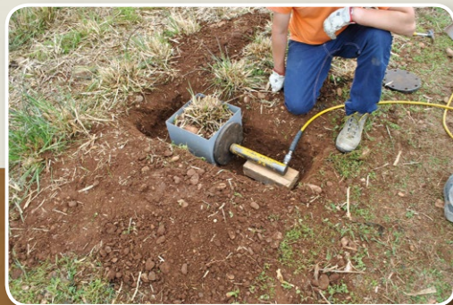
Prove di resistenza al taglio in cantiere
