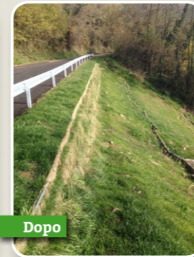
Stabilizzazione di argine fluviale mediante piantumazione di sistemi Erosion Control abbinati a biostuoia in juta
