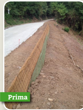
Stabilizzazione di argine fluviale mediante piantumazione di sistemi Erosion Control abbinati a biostuoia in juta
