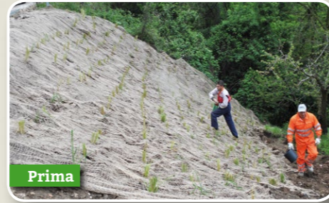
Stabilizzazione di versante stradale mediante piantumazione di sistemi Erosion Control abbinati a biostuoia in juta
