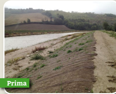
Stabilizzazione di argine fluviale mediante piantumazione di sistemi Erosion Control abbinati a biostuoia in juta
