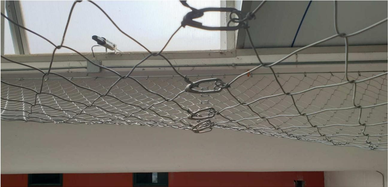
***I pannelli tagliati su misura sono congiunti tra di loro in entrambi i lati con l'impiego di clip T3 e bordati con fune in anima metallica di diametro 8 mm che scorre in clip T3 posti in numero di una ogni due maglie perimetriche dei pannelli in rete***
