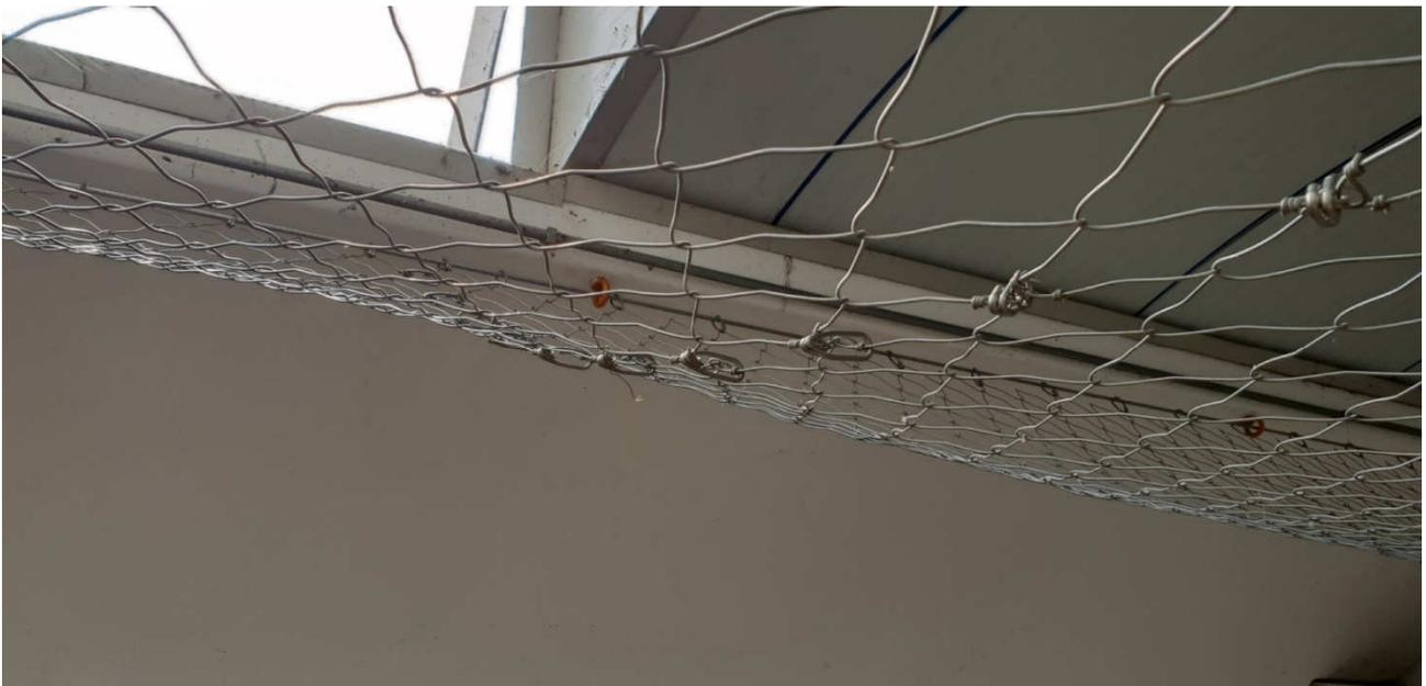
***Primo piano della rete costruita in filo di acciaio armonico ad alta resistenza (1.770 N/mm<sup>2</sup>)***
