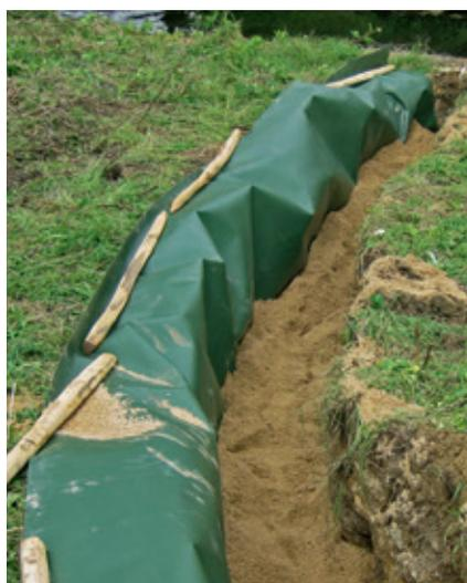
Installazione della soluzione completa Plantex® Platinum, con confinamento laterale dei rizomi mediante Plantex® RootBarrier.
